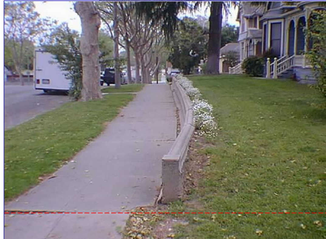
Deformación por creep asociado al trazo de la falla Calaveras, (Hollister, California)
