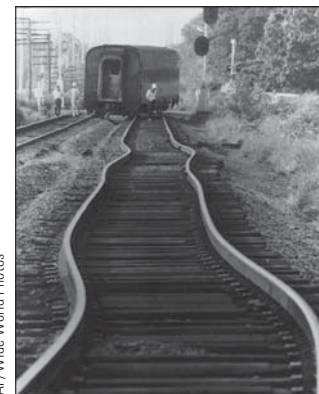
(Ejemplo 10.3) Expansión térmica. El calor extremo de un día de julio en Asbury Park, New Jersey, causó la deformación de estas vías.
